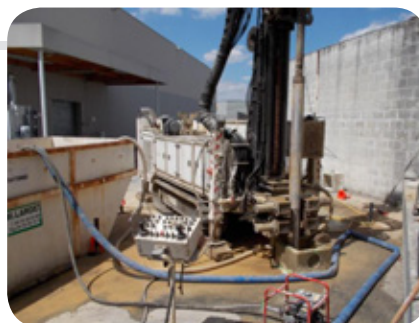
Réalisation de sondages nécessaires au traitement des sols sur le site des anciens ateliers Landis+Gyr de Montluçon
