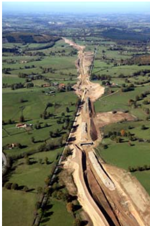
Pendant les travaux
