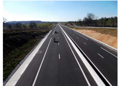
La nouvelle section de la RN7
