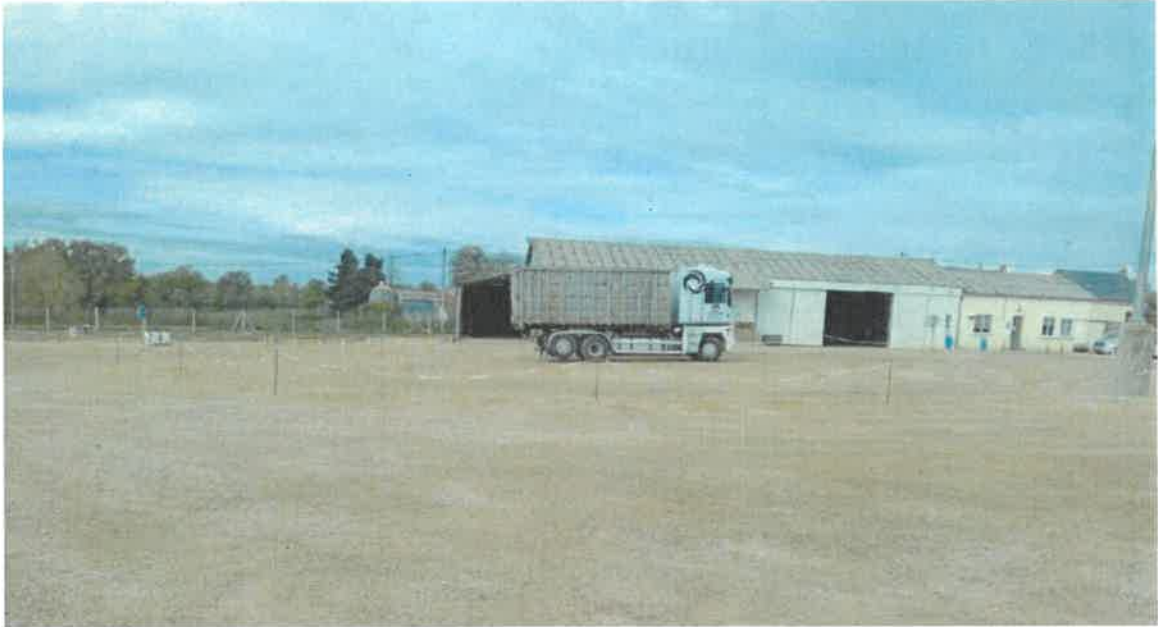
Figure 6 : Photo centre du site (novembre 2022)
