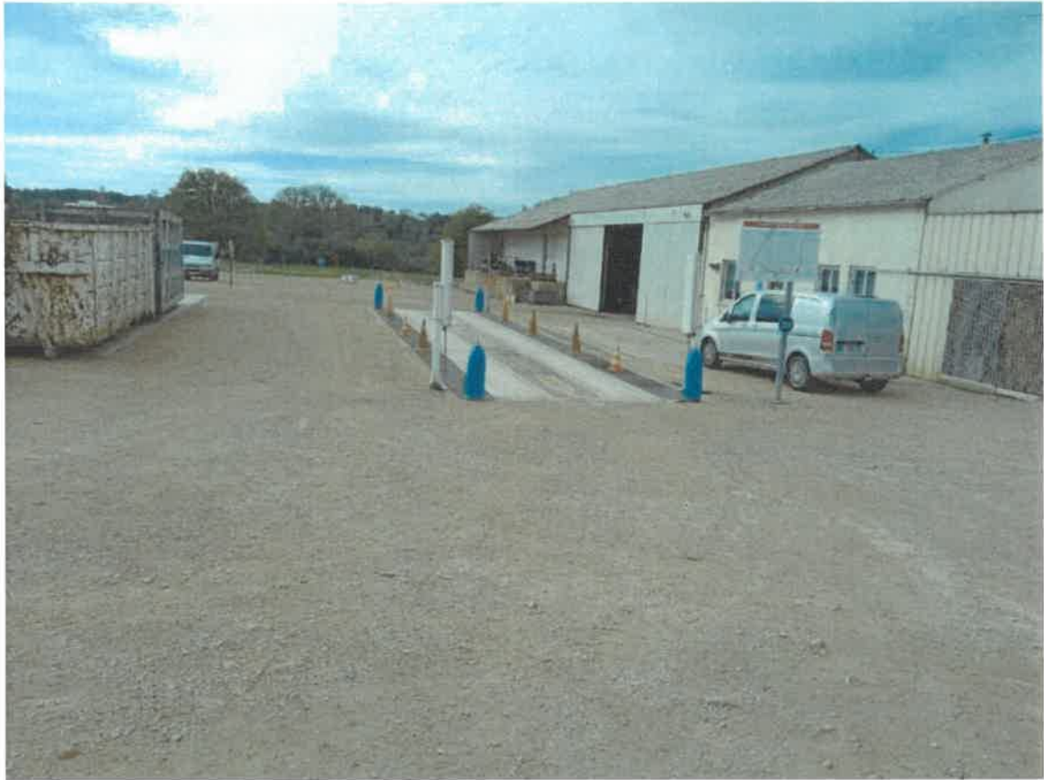
Figure 4 : Photo du pont à bascule (novembre 2022)
