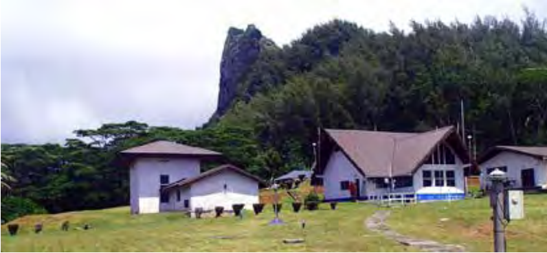
Station météorologique de Rikitea – projet de rénovation énergétique
