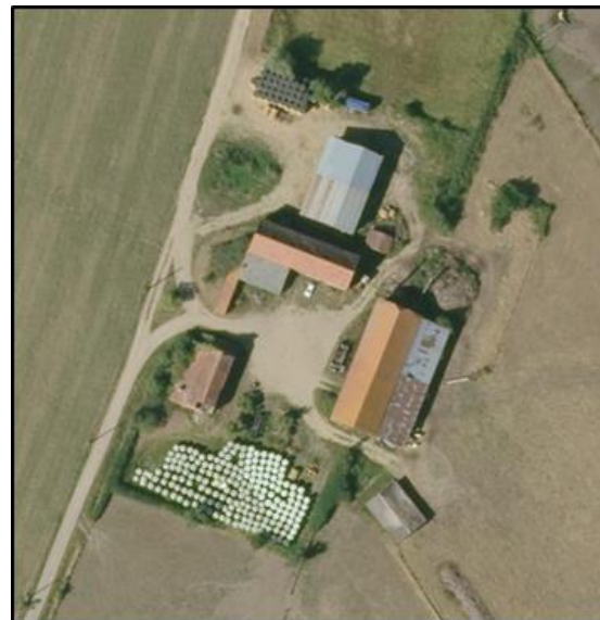
Corps de ferme du Bois de l'Orme (Source : géoportail)
