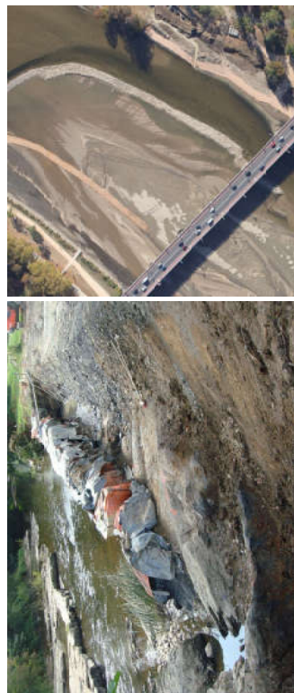
Figure 10 - exemple de big bags le long du cours d'eau pour la mise en place d'enrochements (chantier BPL-La Jouanne) / Chantier de curage du lac d'Allier à Vichy avec création de piste (photographie Véodis-3D).
