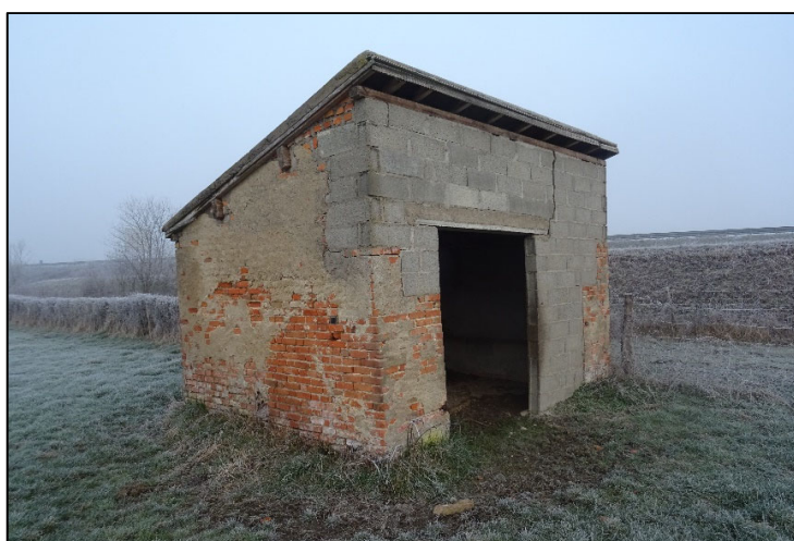
FIGURE 43 – BÂTIMENT POUVANT POTENTIELLEMENT CONVENIR À UN AMÉNAGEMENT - © EGIS
