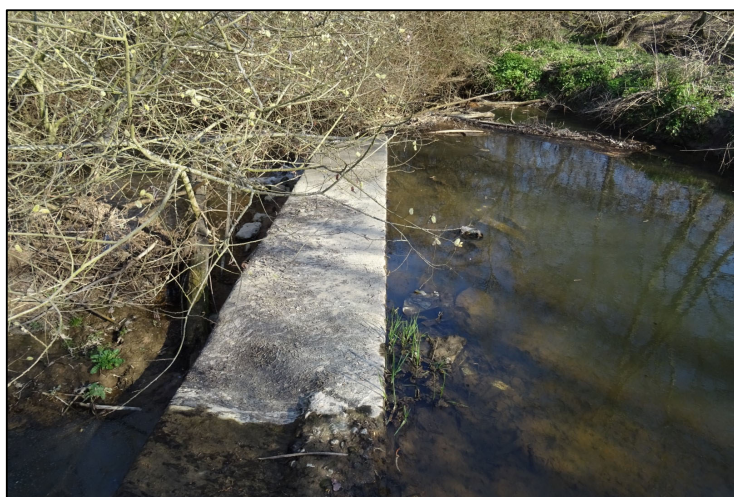
FIGURE 36 – SEUIL SUR LA LOSNE À COULANGE – © EGIS
