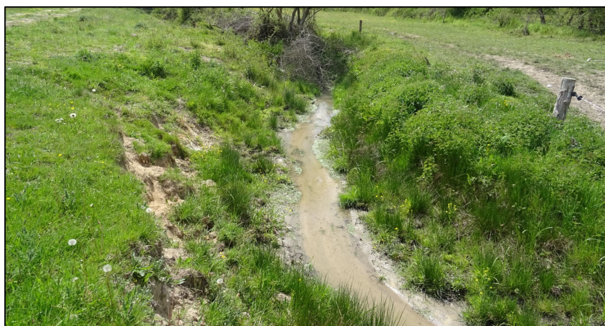
FIGURE 34 – COURS D'EAU RECALIBRÉ – © EGIS
