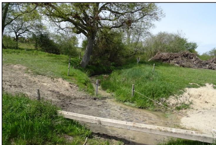
FIGURE 38 – BERGE D'UN COURS D'EAU DÉGRADÉ PAR LE PIÉTINEMENT - © EGIS
