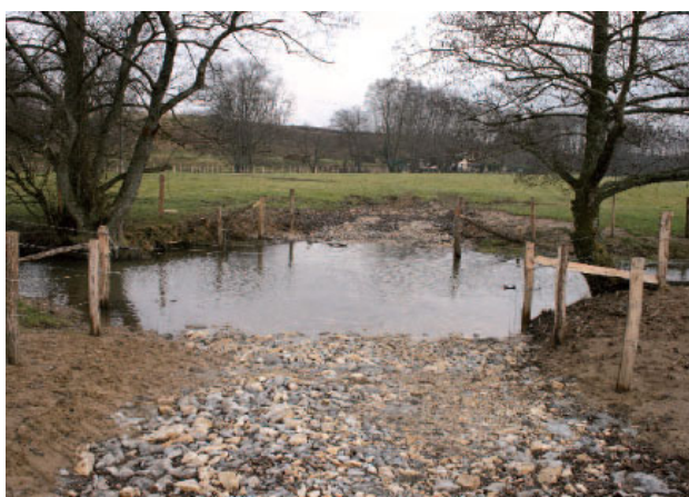
FIGURE 40 – GUÉ STABILISÉ EMPIÉRRÉ - © P. DURLET
