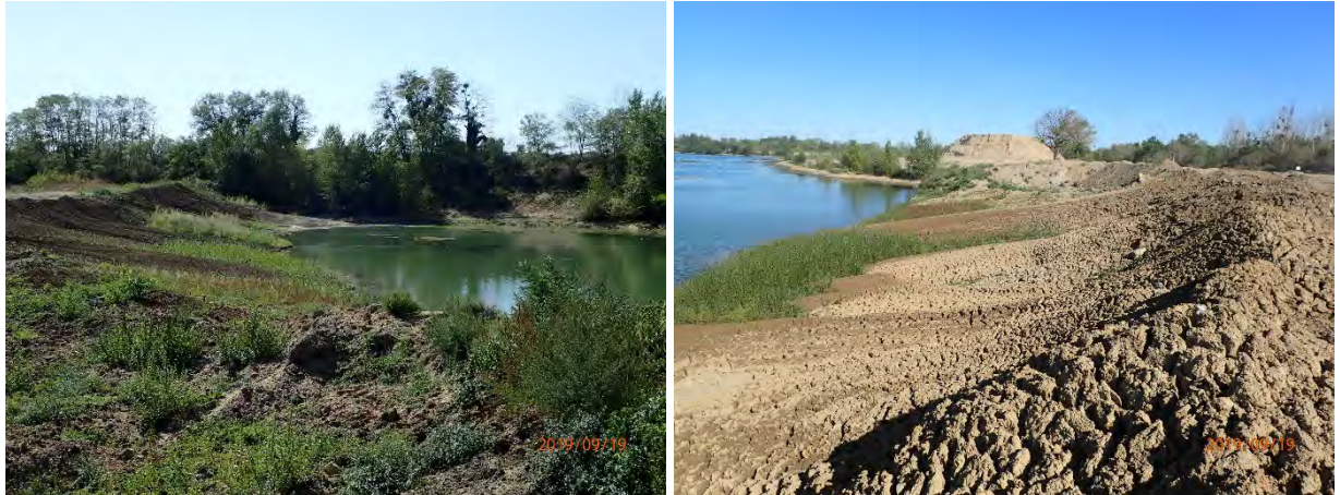
Vues de la zone amont du plan d'eau, remblayée depuis 2013
