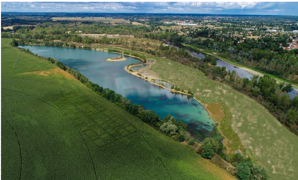
Vue aérienne de la gravière après remise en état (photomontage)
