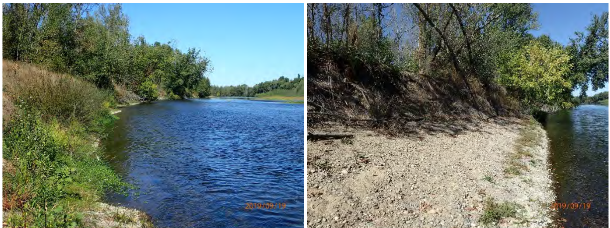
Berge RG de l'Allier et encoche d'érosion
