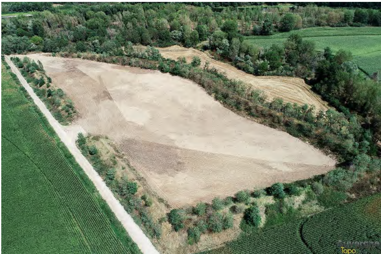
Vue de la parcelle 169 remise en état (2019)
