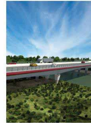
Viaduc de l'Allier © Néel Architecture
