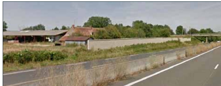
Vue du mur d'enceinte et de l'habitation riveraine depuis la chaussée de la RN79.
