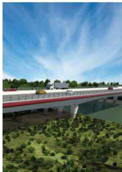
Viaduc de l'Allier © Néel Architecture
