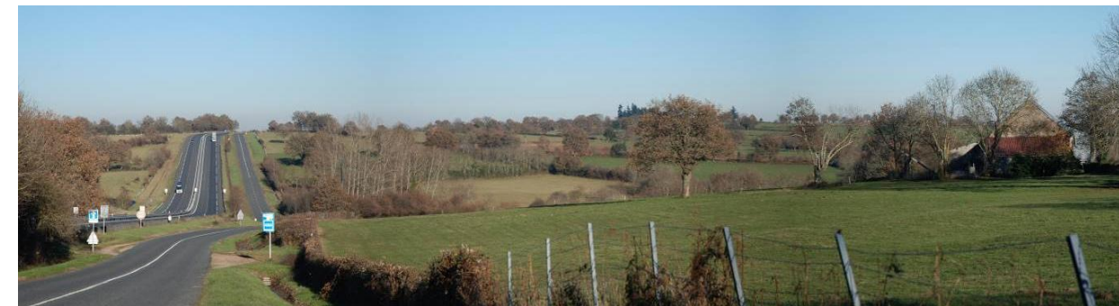
Photo 6 : Entre Montmarault et Les Deux Chaises, section à 2 x 2 voies jumelée à l'ancienne route nationale
