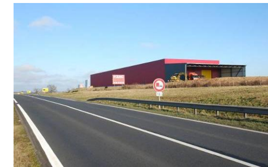
Photo 4 : Passage inférieur de la RD65 à Cressanges (face sud)
