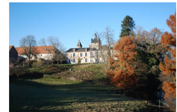
Photo 8 : Château de Bouillé
