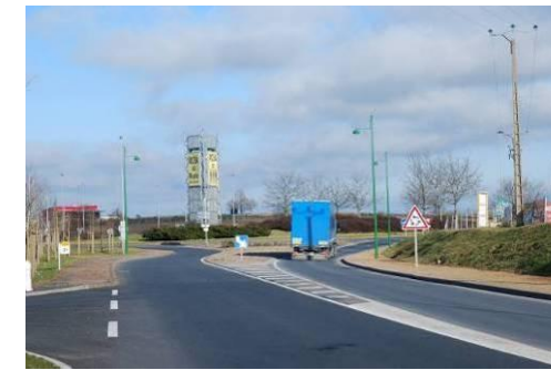
Photo 3 : Passage inférieur de la RD65 à Cressanges (face nord)
