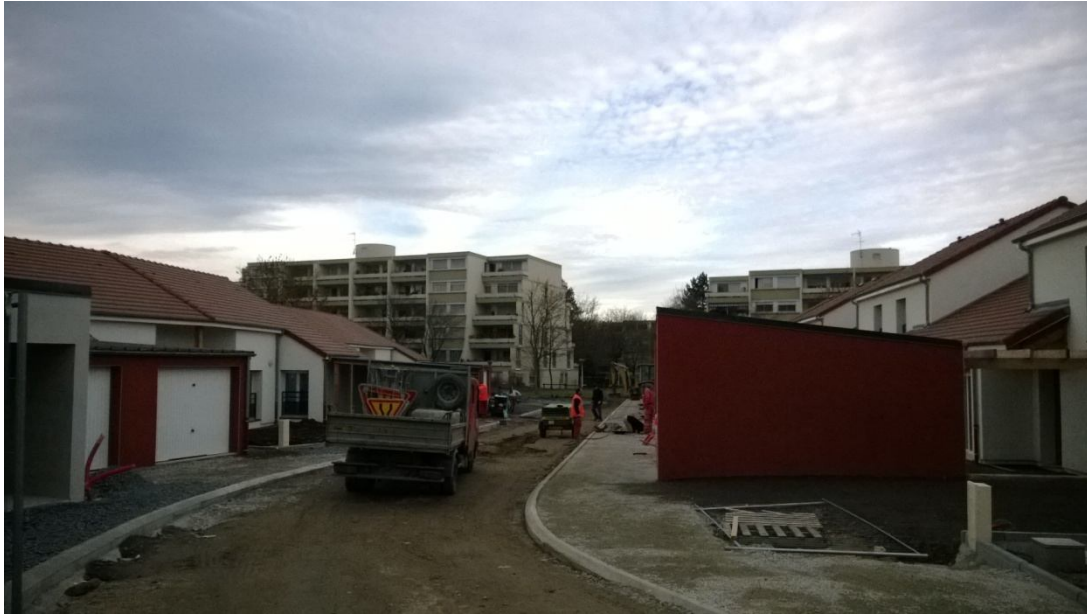
Construction de logements locatifs sociaux individuels (contribuant à la reconstitution de l'offre démolie)
