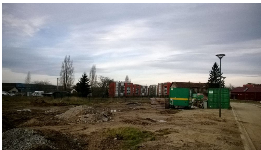
Espace en cours d'aménagement entre les Ozières et le Plessis
