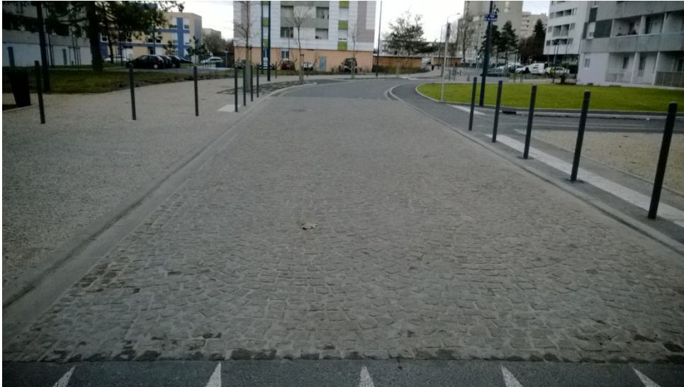
Aménagement des voiries et des trottoirs
