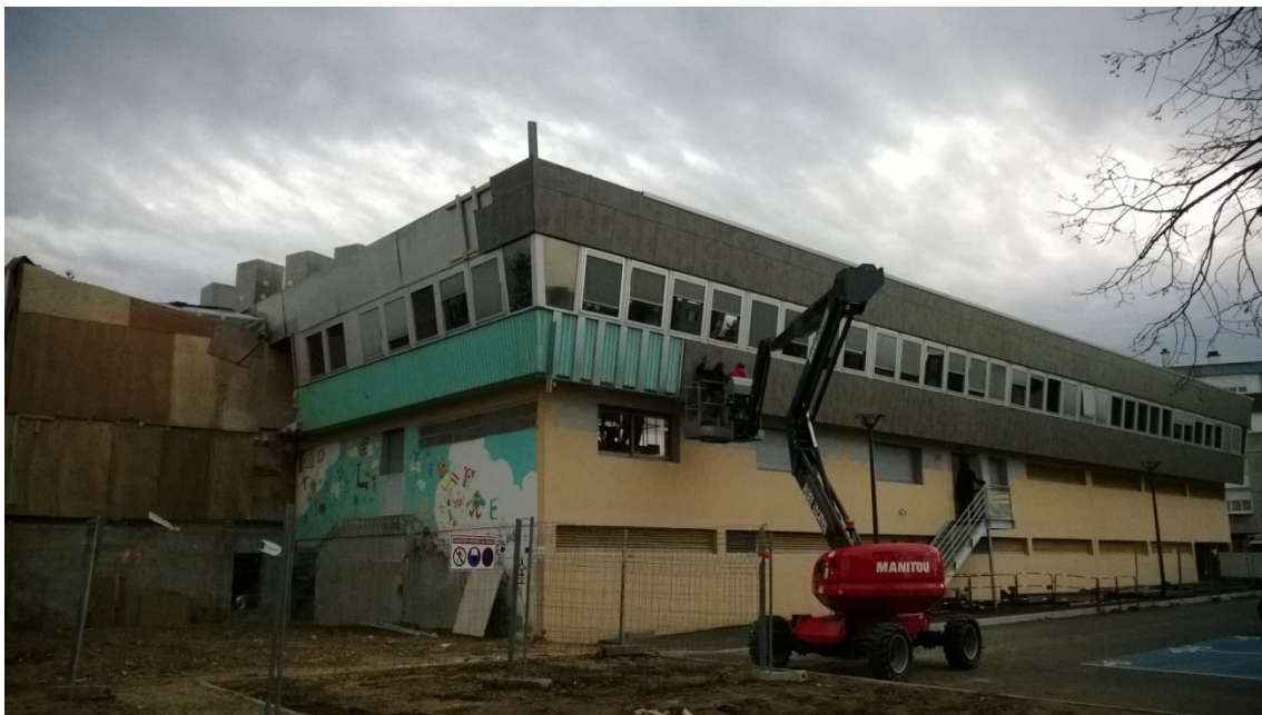
Travaux en cours sur la façade du Florilège
