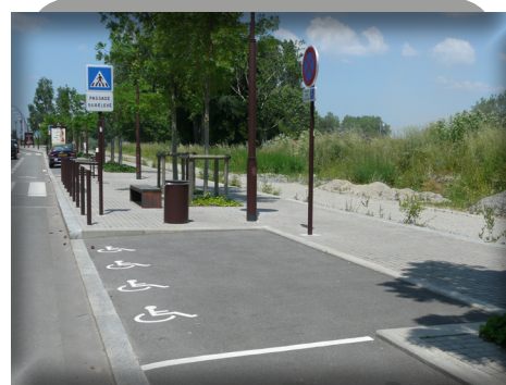
Une place de stationnement réservée disposant des signalisations verticale et horizontale en vigueur.
