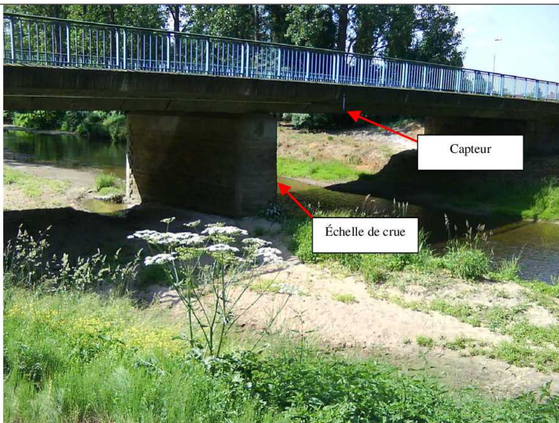
Face aval du pont de la RD11 à Cosne d'Allier : situation du capteur et de l'échelle de mesure
