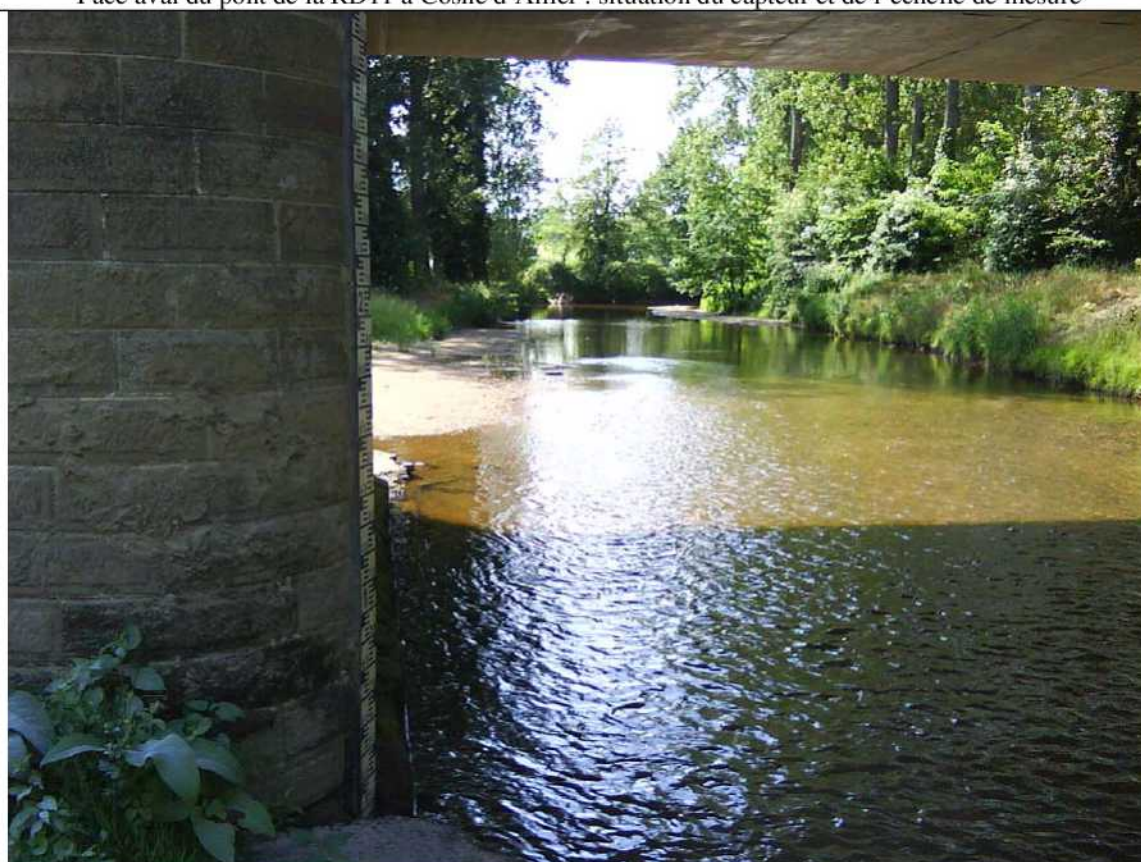
Face aval du pont de la RD11 à Cosne d'Allier : échelle de mesure
