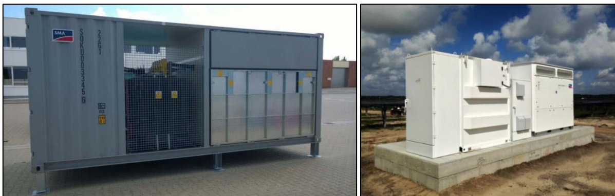
Illustration 46 : Exemple de postes de transformation « container » ou « outdoor »
