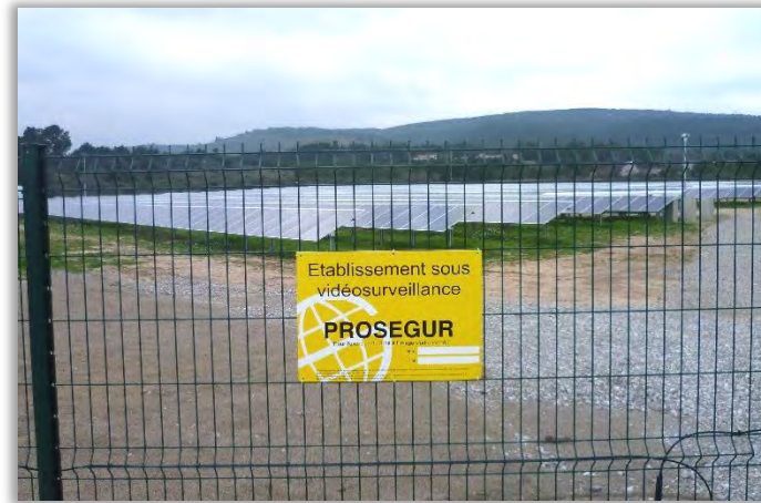
Signalétique de sécurité sur la clôture - Source : LUXEL, 2011
