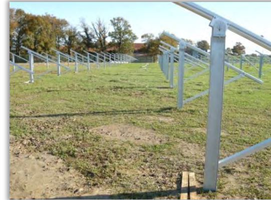
Structures prêtes à recevoir des modules
