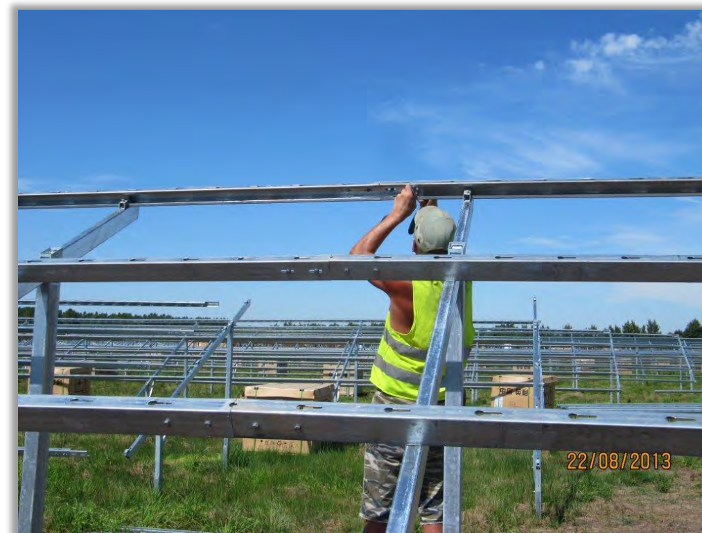
Systèmes de fixation pour installation photovoltaïque - Source : LUXEL, 2013
