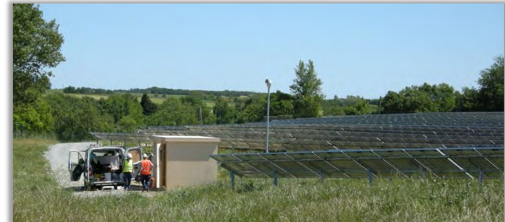
Opération de maintenance – Source : Luxel
