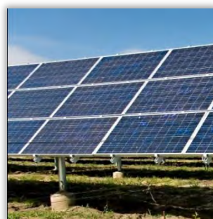
sur plots béton
