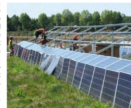
Pose manuelle des modules - Source : Luxel
