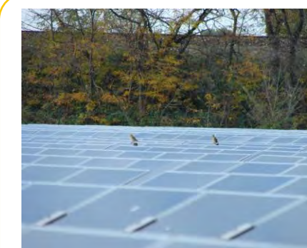
Avifaune présente sur une centrale photovoltaïque
