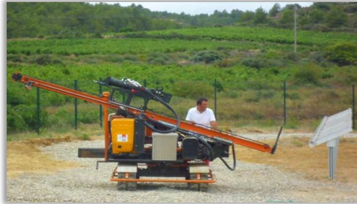
Machine de battage de pieux
