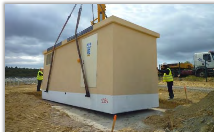
Schéma de dépose des postes préfabriqués - Source : Transfix Photo de pose de poste préfabriqué – Source : LUXEL 2010
