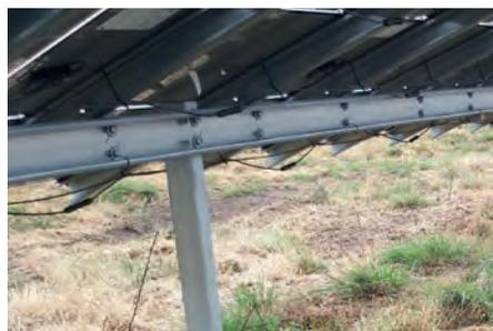
**Photo 38 :** Exemple de fixation de câbles électriques avec des serre-câbles à l'arrière d'un panneau photovoltaïque (©Idele)
