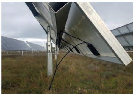
**Photos 34 et 35 :** Les câbles électriques ont tendance à pendre à faible hauteur, à l'arrière des panneaux, engendrant un risque d'étranglement, en particulier chez les jeunes animaux. (©Idele)
