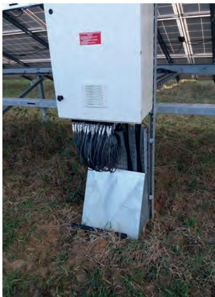
Photo 33 : Câblages électriques laissés apparents à faible hauteur pouvant être rongés par les animaux (© Idele)
