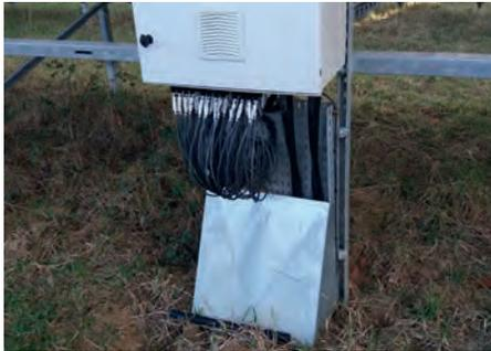
Photos 64 : Présence de câble à 50cm de haut, risque d'endommagement de la structure sans protection (© Idele)
