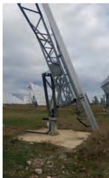
Photo 31 : Double-tracker mono-pieu sur dalle de béton (© Idele)
