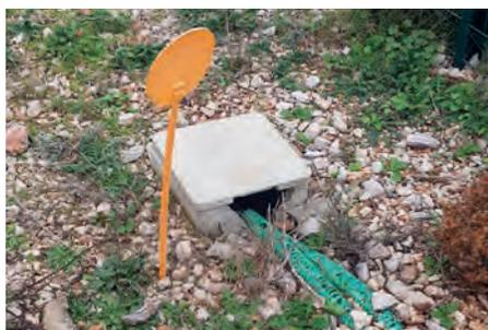
**Photo 37 :** Exemple de regard pouvant être présent dans un parc photovoltaïque (©Idele)
