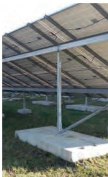
Photo 30 : Table fixe bi-pieux sur dalle de béton (© Idele)
