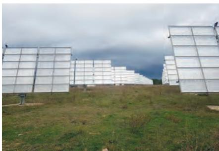
Photo 16 : Panneaux photovoltaïques trackers 2 axes à Grabels (34) (© Idele, parc géré par Neoen)
