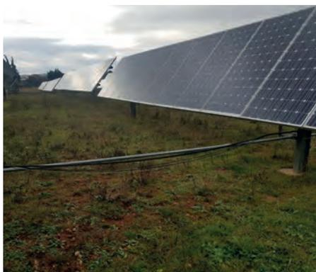
Photo 25 : Des barres de commande trop basses dans un parc photovoltaïque trackers 1 axe d'ancienne génération (©Idele)
