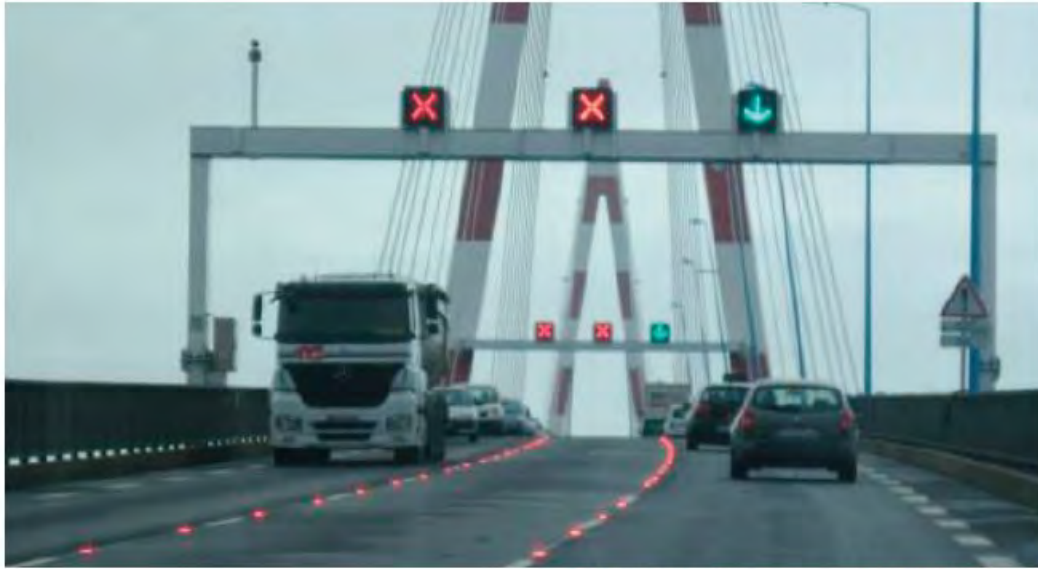
Signalisations lumineuses en voie réversible fermée
