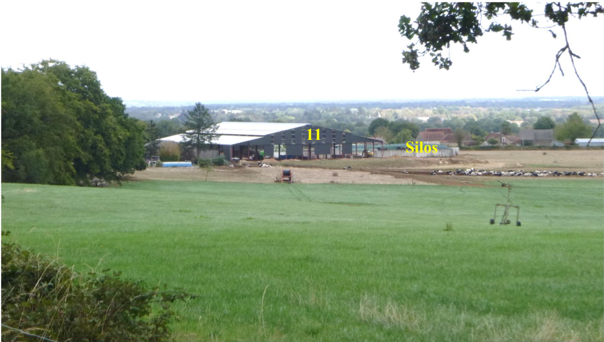
Photo 4 : Le site vue de l'ouest (à proximité de la cote 279 sur la carte topographique IGN). C'est de ce point de vue que la nouvelle stabulation est la plus visible.
