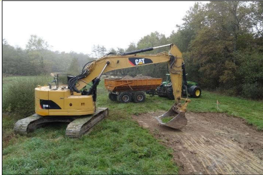
Creusement d'une mare – © Egis
